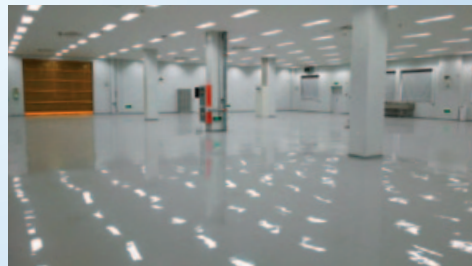
高鳥（常熟）精密機械有限公司 工場内装工事完成
